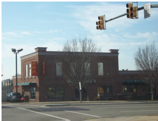
Figure 4: Nouveau McDonald's dans une zone historique de Columbia, Caroline du Sud, États-Unis. La nouvelle construction n'a pas l'aspect caractéristique d'un McDonald's, mais a l'architecture traditionnelle de la région (matériaux et couleurs). Le deuxième faux étage est bâti pour s'encadrer à la hauteur de la zone.
