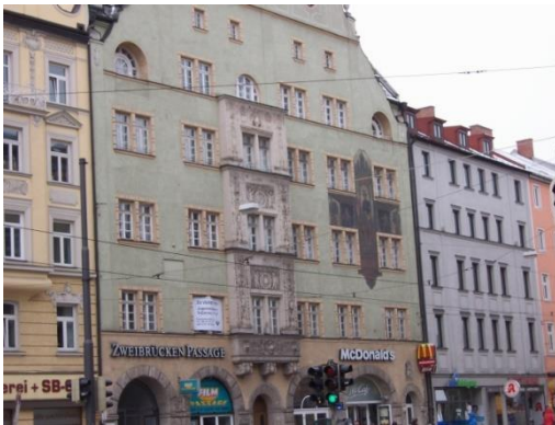
Figure 1: Préservation d'une façade historique à Munich, Allemagne : malgré le fait que la fonction d'un bâtiment a changé radicalement et le caractère historique de la zone est perdu. Photo prise par Alexandru-Ionuț Petrișor
