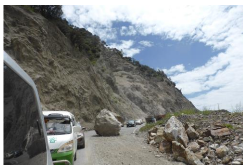
Figure 22. Éboulement sur la route
