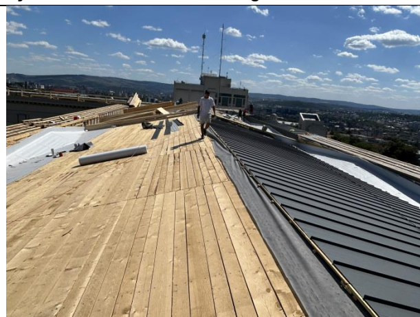
În timpul lucrărilor
